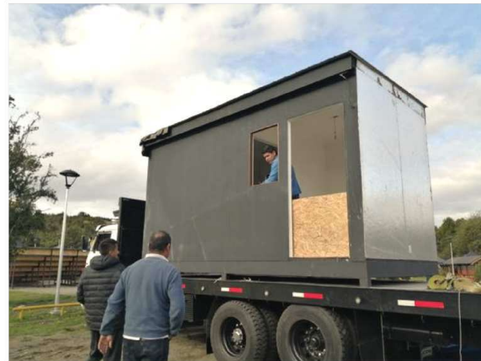
Adecuación de cubierta, Transporte e Instalación del módulo prefabricado.
